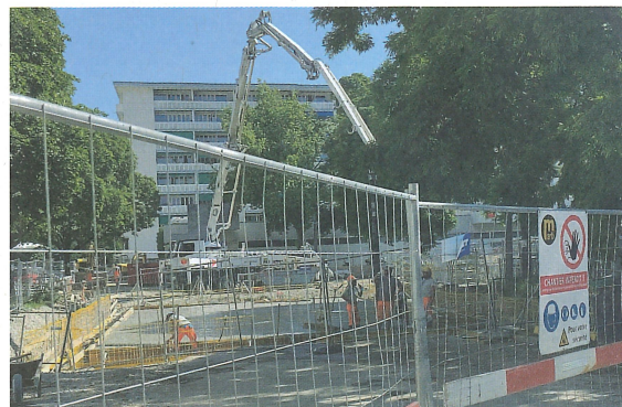
Travaux de transformation du parking en parc - juin 2025
