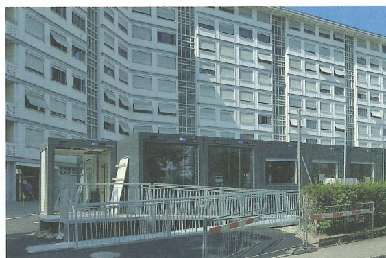
Installation du magasin Coop provisoire à la rue Camille-Martin sur l'ancien terrain de basket
