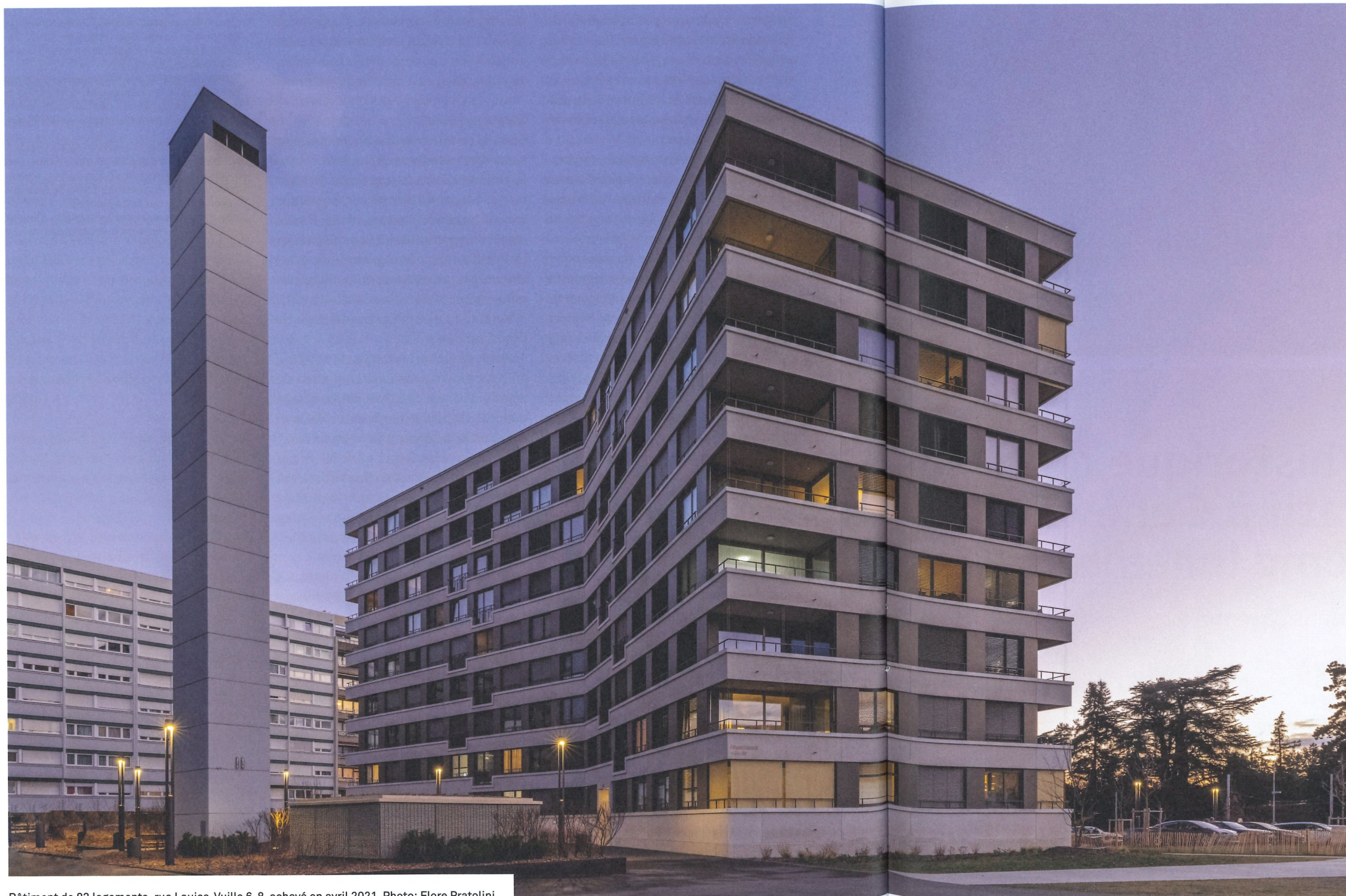
Bâtiment de 83 logements, rue Louisa-Vuille 6-8, achevé en avril 2021. Photo: Flore Pratolini
