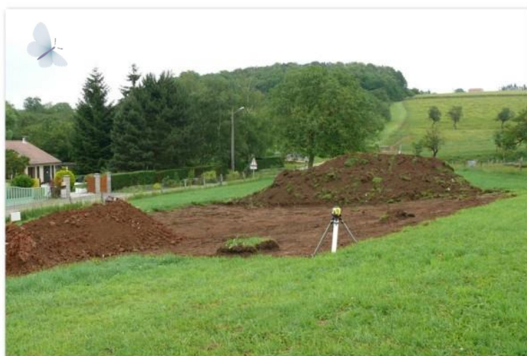
Exemple de dépôt de terre végétale
