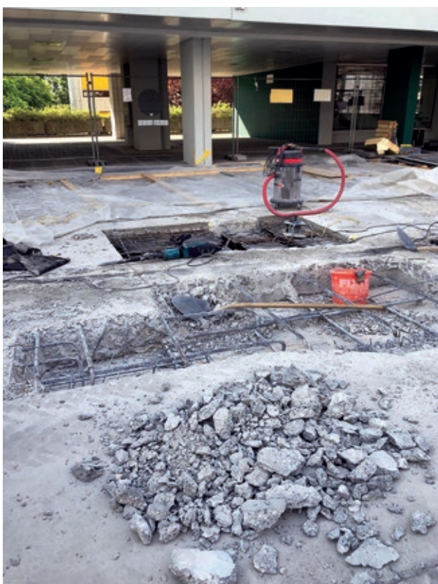
VIEUSSEUX 2 À 6 : RÉFECTION DES DALLES (TRAITEMENT CARBONATATION)
