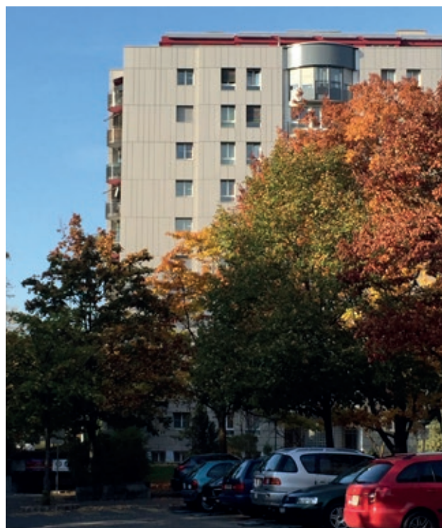
VIEUSSEUX 12 APRÈS RÉNOVATION DES FAÇADES
