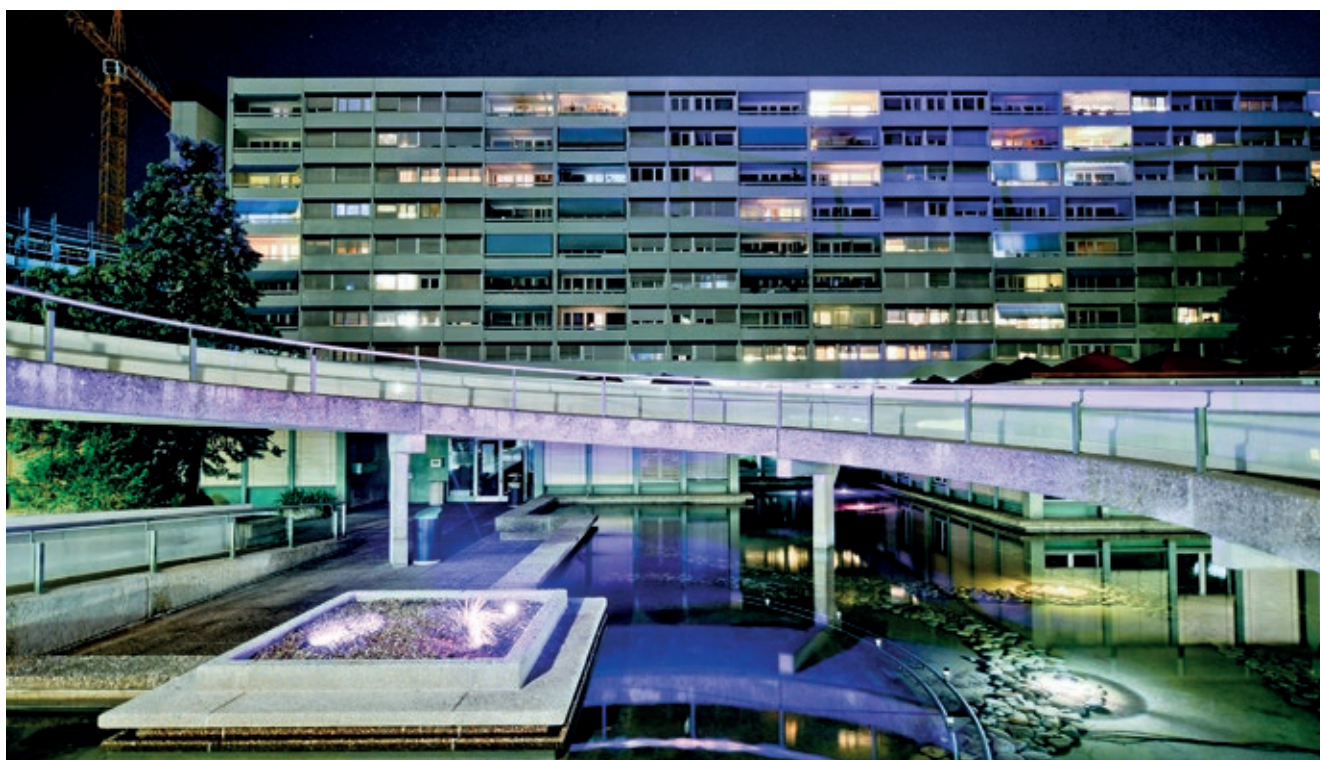
VIEUSSEUX 1 À 7 : VUE DEPUIS LE BASSIN DE LA FONTAINE
