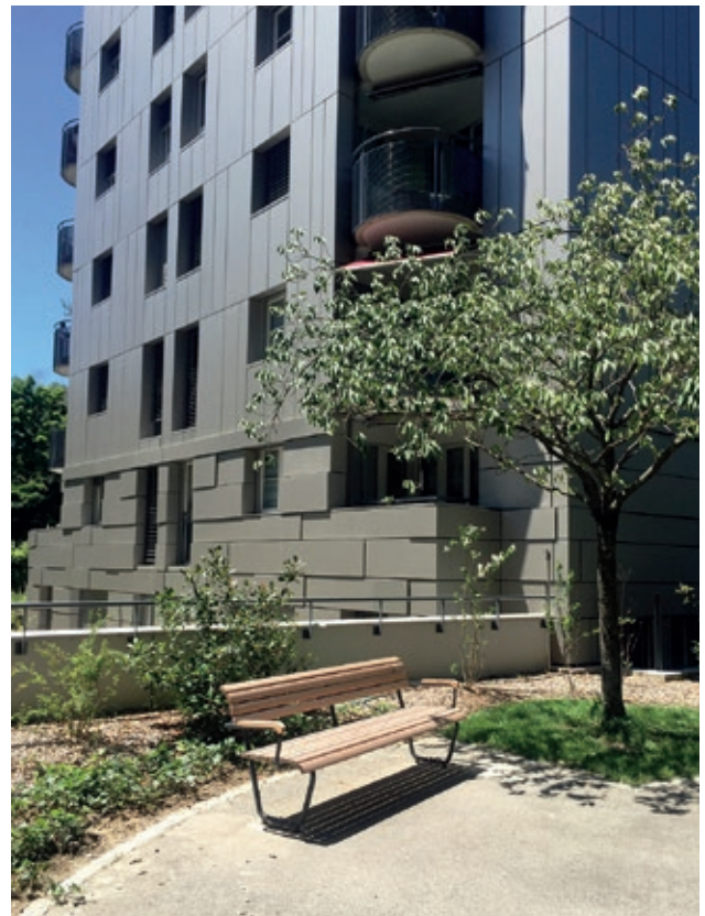
VIEUSSEUX 12: PLACETTE DEVANT LA FAÇADE RÉNOVÉE
