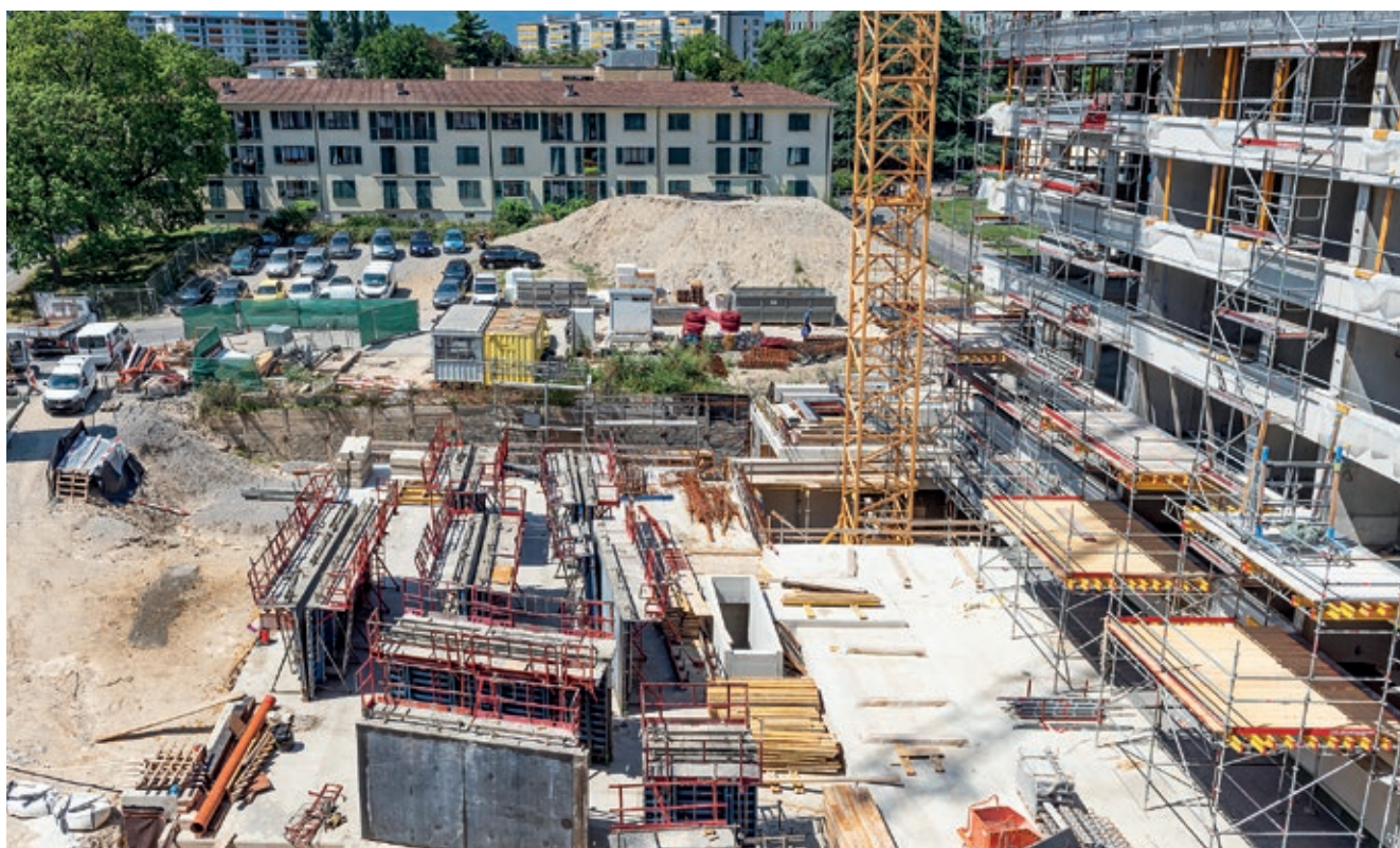
CHANTIER VVF PAPILLON: VUE DU BÂTIMENT A EN CONSTRUCTION (DROITE)
