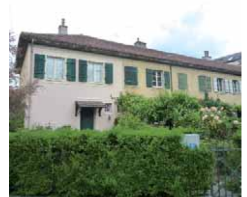
Sports 1-11 (avant rénovation)
