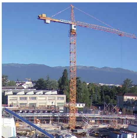
Chantier LMI, Parc Hentsch
