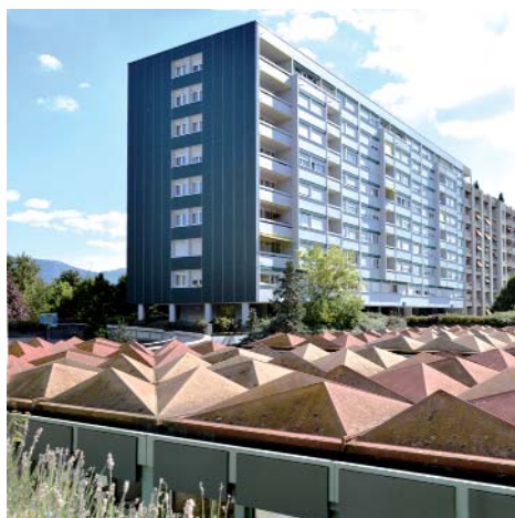
Vieusseux 2-6: façades rénovées
