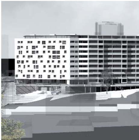
Vieusseux 23 / Façade Nord
