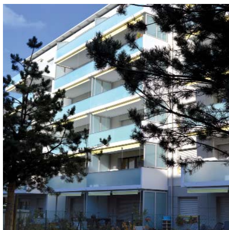
Bâtiment rue Edouard-Rod 4 a, b, c
