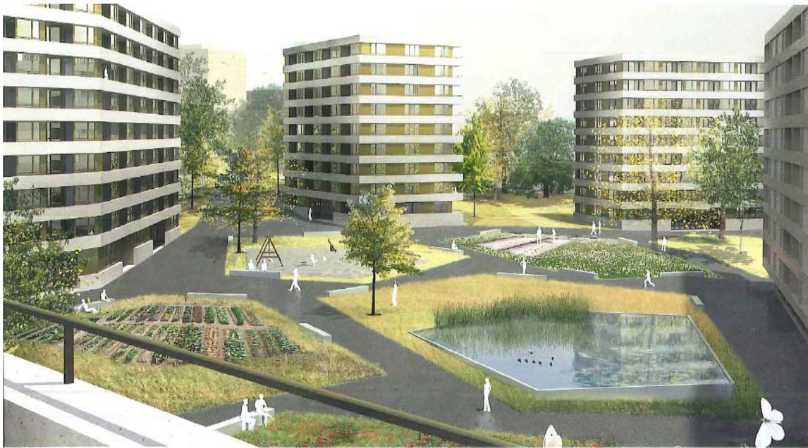
Démarrage en mai-juin d'une réalisation de 63 logements, préambule à la réalisation du projet Papillon (550 logements) sur le site emblématique de la SCHG, près de la Servette. ©Timothée Giorgis Architectes
