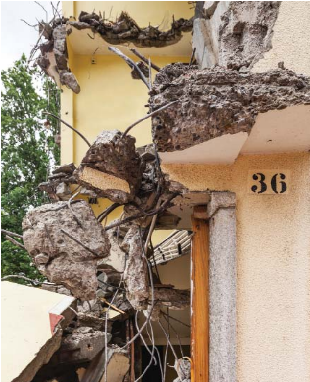
Vue de la démolition de Cité Franchises 36
