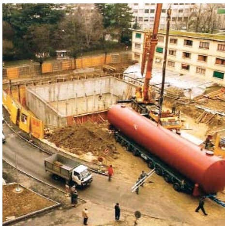
Au temps jadis: installation des citernes à mazout à Vieusseux en 1986
