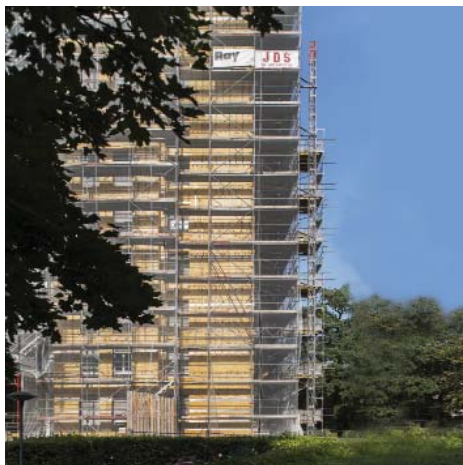
Réfection des façades de Cité Vieusseux 12
