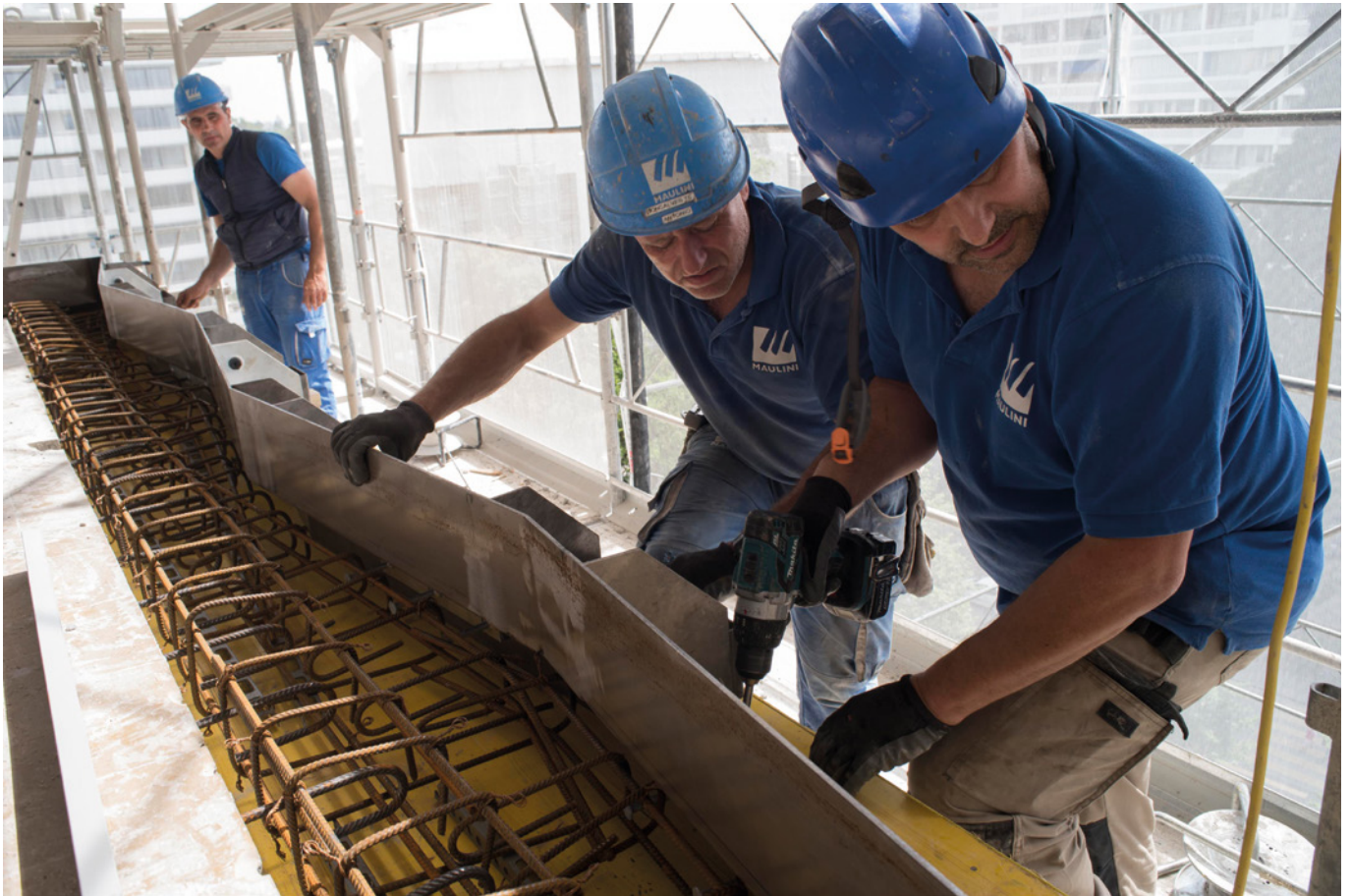
LES MAÇONS POSITIONNENT LE COFFRAGE DANS LEQUEL LE BÉTON SERA COULÉ POUR AGRANDIR LE BALCON, DONT ON VOIT LA DALLE À GAUCHE.
